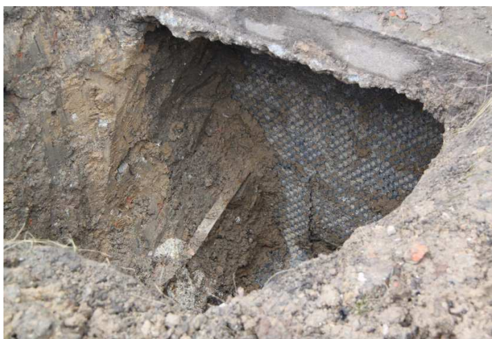
Odkrywka w ścianie zewnętrznej północnej.
