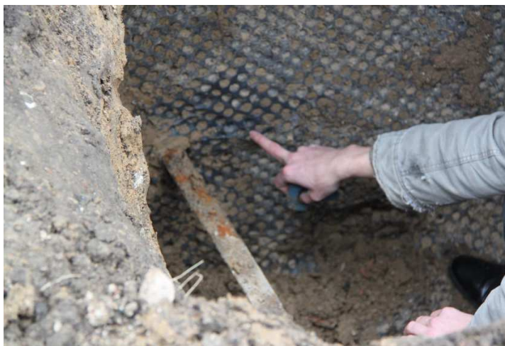
Bednarka przechodząca przez izolację z folii bąbelkowej.
