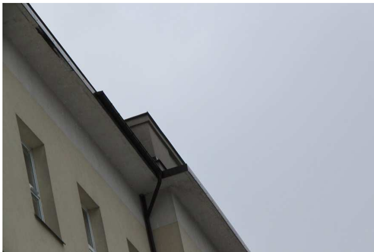
Próba odwodnienia gzymsu.
