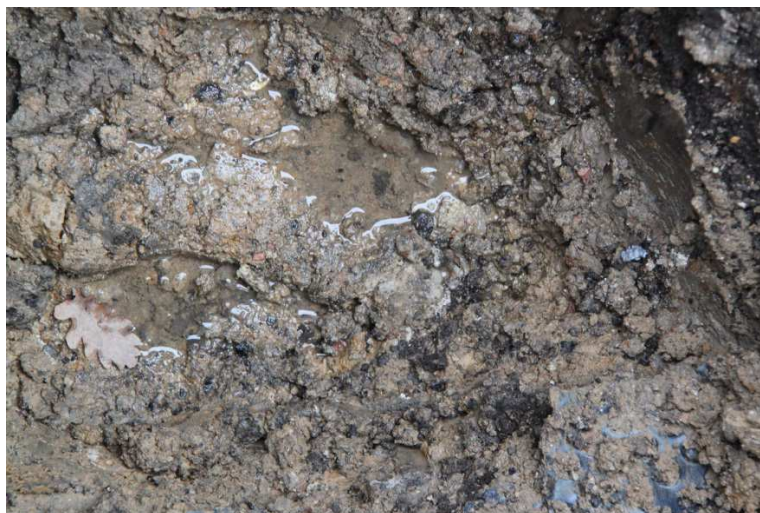
Nawodniony grunt nasypu.
