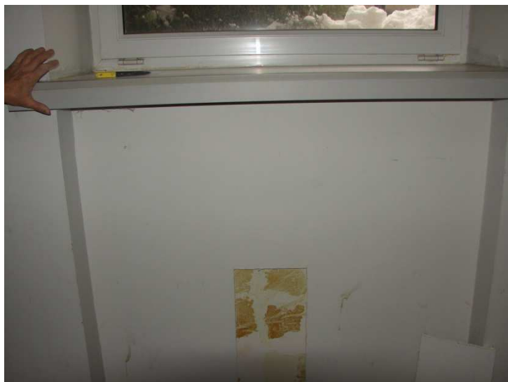
Odkrywka wewnętrzna nr 2 ściany zewnętrznej piwnic.
