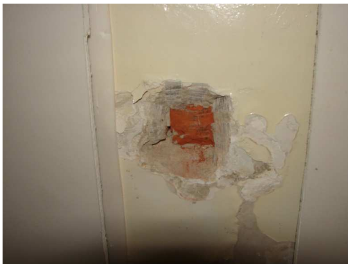
Odkrywka wewnętrzna nr 1 ściany piwnic- ściana murowana z cegły ceramicznej pełnej.
