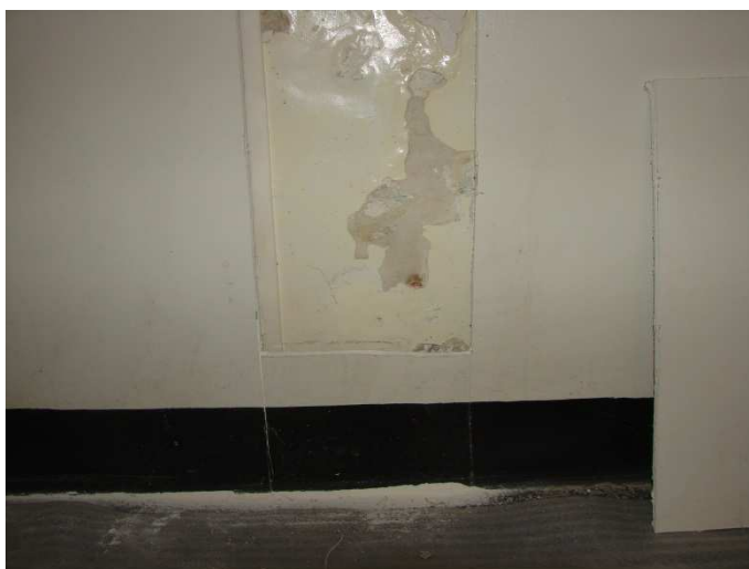
Odkrywka wewnętrzna nr 1 ściany piwnic.
