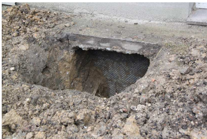
Odkrywka zewnętrzna ściany zewnętrznej.
