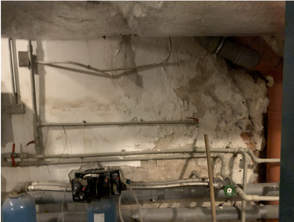
Zdjęcie 1 widoczne odparzone i odspojone tynki na ścianie zewnętrznej piwnicy.
