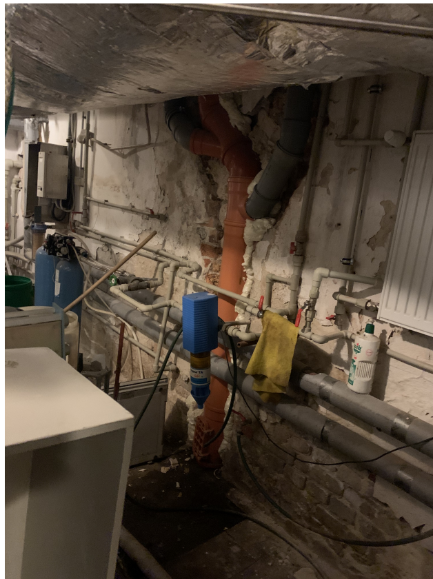
Zdjęcie 2 Widoczne odspojone i rozwarstwione tynki, brak tynków przy poziomie posadzki.
